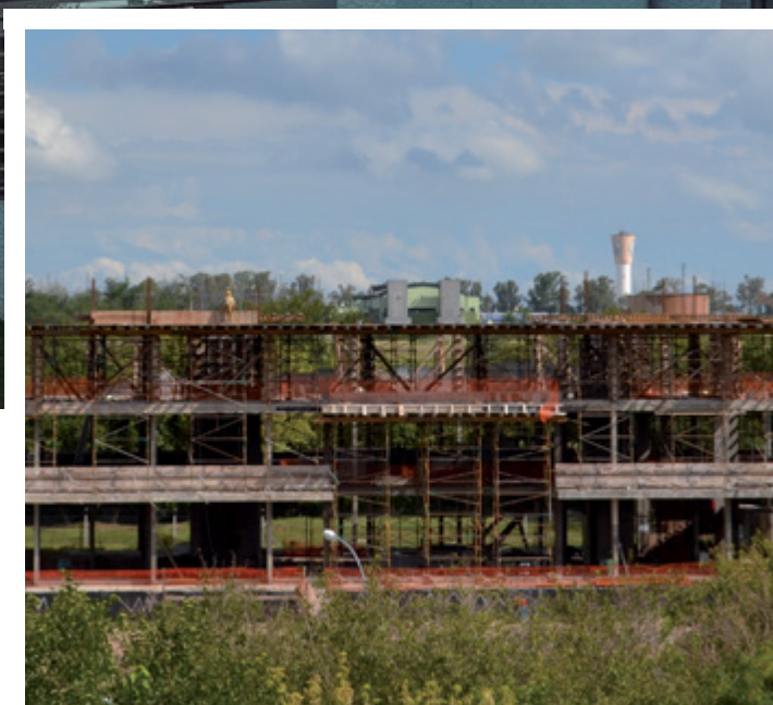
Avance en las obras del Edificio Corporativo en Manantiales.
